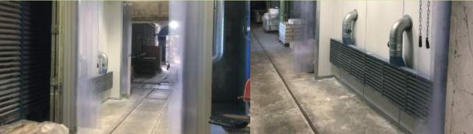
Überall, wo flächig Rauch, Staub, Späne und Gase aus einem Raum abgesaugt werden sollen, sind die Absaugwände sowie Absaugpaneele von VAUPEL die richtige Wahl.
